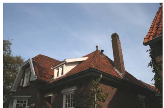
Dak met schoorsteen
