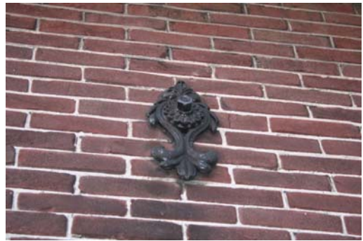
Detail sieranker en metselverband
