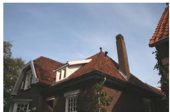
Dak met schoorsteen
